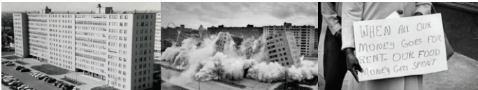
The Pruitt – Igoe, St. Louis, Missouri, výstavba bytů 1954, demolice domů, 1972 – 76.
