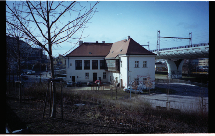
Žižkov čp. 1, bývalá usedlost Hrabovka, Trocnovská 1, Praha – Žižkov
