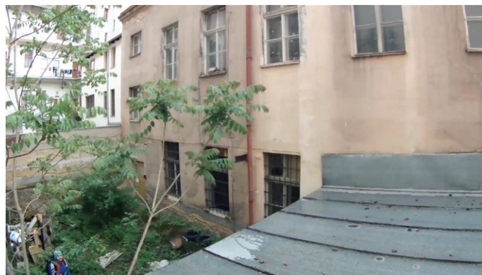
Vnitroblok sv. Kříže, bývalá továrna na azbest, pohled ze dvora
