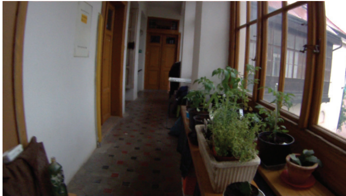
Bývalá usedlost Hrabovka, pavlač
