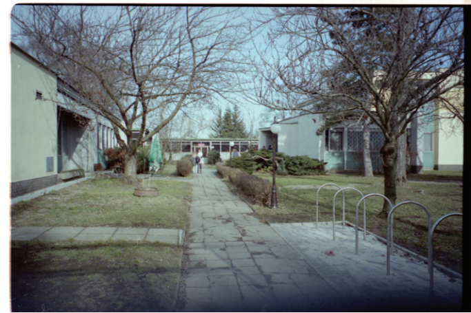
Bývalé jesle, pohled od hlavního vstupu, vlevo hospodářský pavilon
